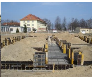
Początek budowy budynku J 2011 r.
