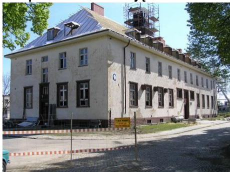
Budynek C Biblioteka Główna
