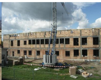
Budowa budynku J wrzesień 2011 r.
